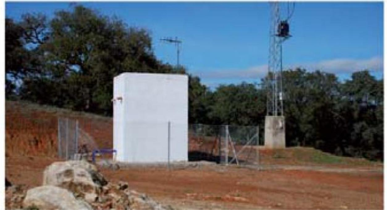
Caseta que alberga el sondeo de abastecimiento a Almadén de la Plata. Está emplazado en la zona oriental del Cerro de los Covachos, tiene 350 m de profundidad y está perforado totalmente en calizas marmóreas y mármoles, como los que se ven en el primer plano de la foto
